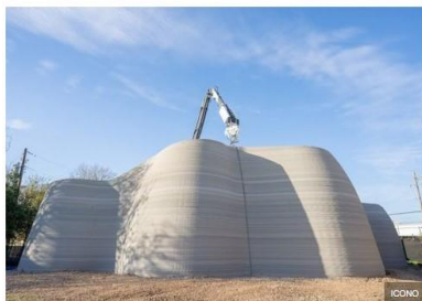
La Phoenix de ICON (EE. UU.) es una impresora 3D que puede producir un edificio de 8 metros de alto en 400 horas. Está a punto de lanzar su hormigón patentado con bajas emisiones de carbono, CarbonX.
