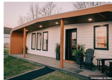
La Universidad de Maine (EE. UU.) ha impreso en 3D su BigHome3D totalmente reciclable a partir de serrín, que tiene un 30% menos de huella de carbono que una casa construida de forma tradicional.
