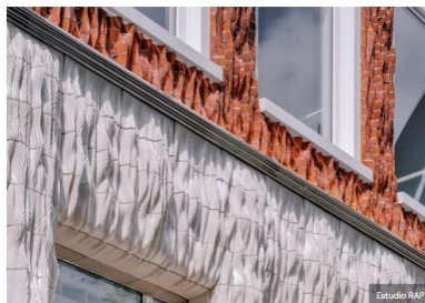
El estudio de arquitectura holandés Studio RAP utilizó baldosas de cerámica impresas en 3D para crear una fachada que imita los pliegues, hilos y patrones de puntadas de los textiles.
