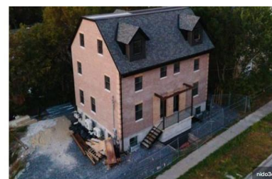
La empresa constructora canadiense nidus3D imprimió en 3D una casa de tres pisos y 8.740 pies cuadrados revestida de ladrillo para conservar una apariencia tradicional.
