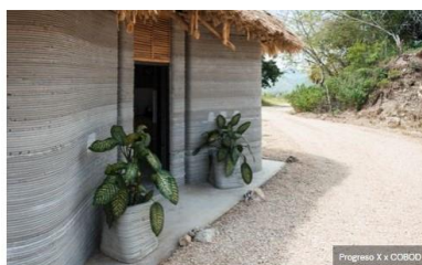
Progreso X en Guatemala se asoció con COBOD para fusionar lo antiguo y lo nuevo imprimiendo una casa de 49 metros cuadrados en 26 horas y optando por un techo de hojas de palma para alinearse con la estética regional.
