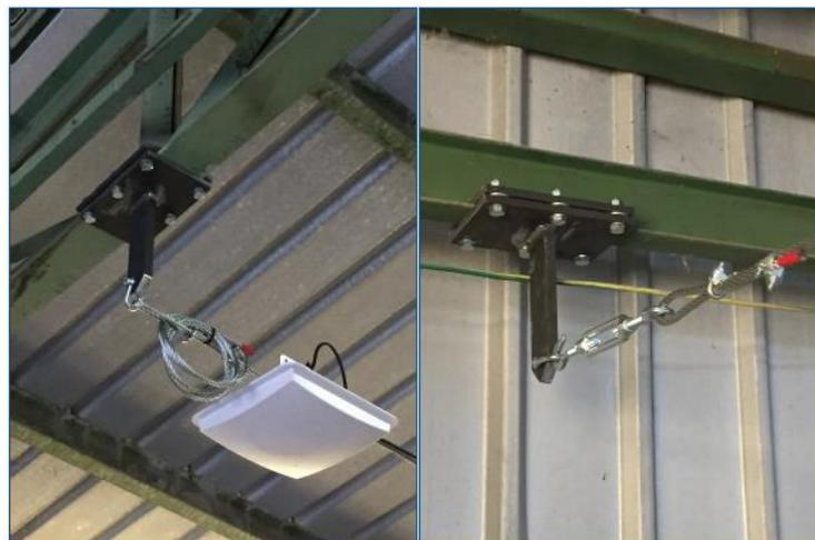
Figura 6 Detalle de los anclajes
