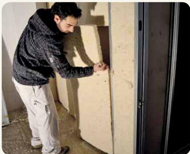
Imagen 1. Instalación "in situ" del material WOOL4BUILD en la celda de medida, y comparación con una instalación idéntica con lana de roca.
